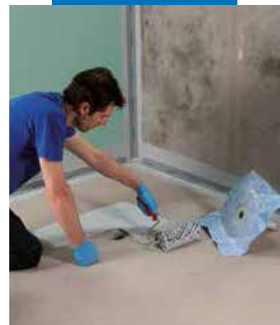
Полагане на воронка на отводнител с помощта на Mapegum WPS
