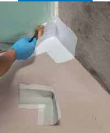
Полагане на 90° ъглова лента Мареband PE 120 с помощта на Марегум WPS
