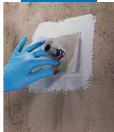
Полагане на уплътнител Mapeband PE 120 за проходни отвори с помощта на Mapegum WPS
