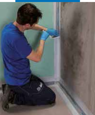
Полагане Мареband PE 120 с помощта на Марегум WPS
